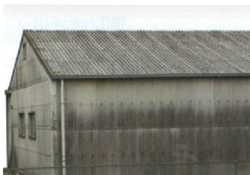
屋根に使用した例(成形板波板)
