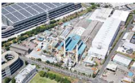
千葉工場全景
