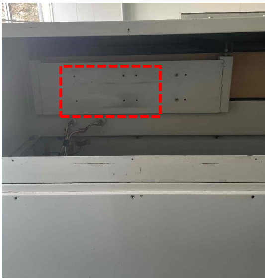
(写真3) 安定器設置箇所(安定器取り外し後)
