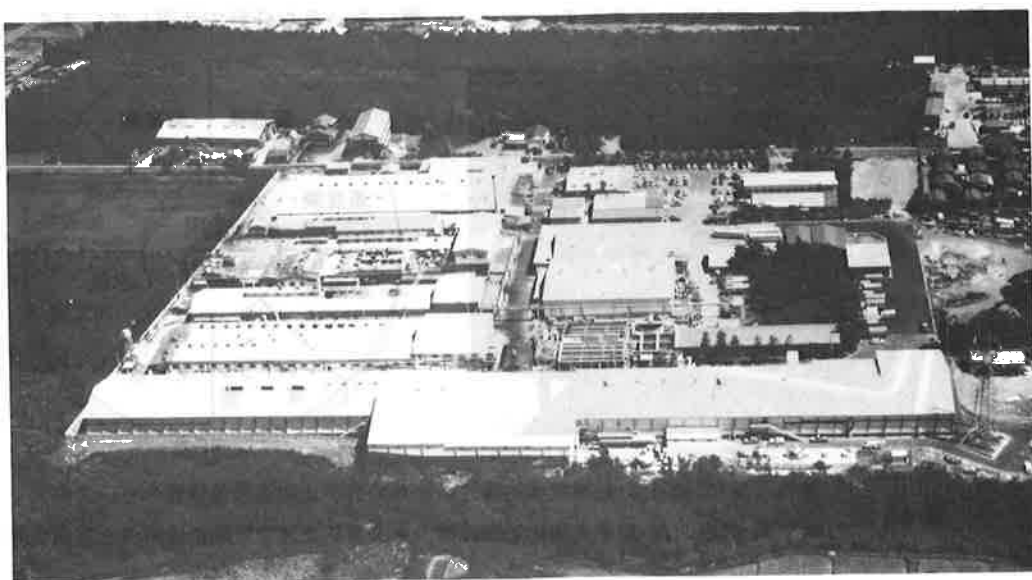
手前の白い建物が新設ハンバーグ工場です。(建物全長243m)
