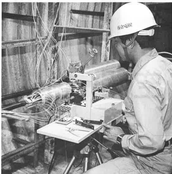
(光ファイバケーブル接続作業)
