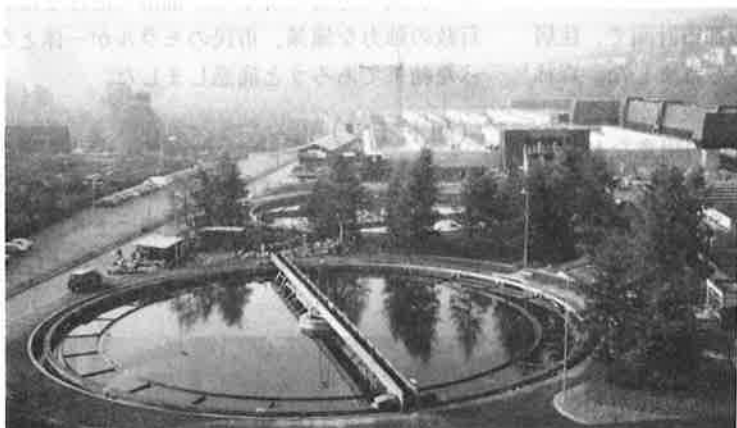
ベルトヘルツウィ工場（汚水処理場））スイスのチューリッヒ
