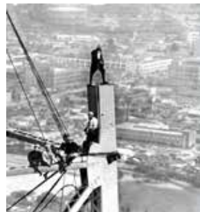
東京タワー建設写真 (毎日新聞 昭和毎日より)
