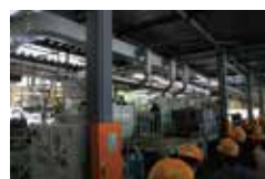
(株)ハイパーサイクルシステムズ：エアコン解体工程
